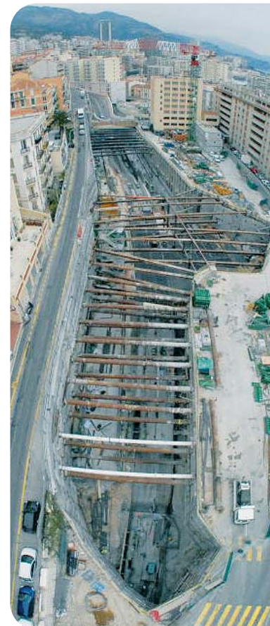
Les travaux en cours de la dorsale
